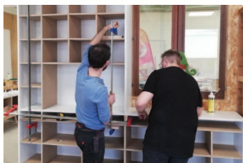
Aménagement de la salle de classe par les apprentis
