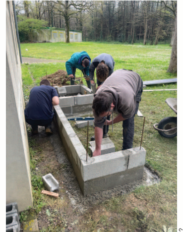
Pratique de la maçonnerie
