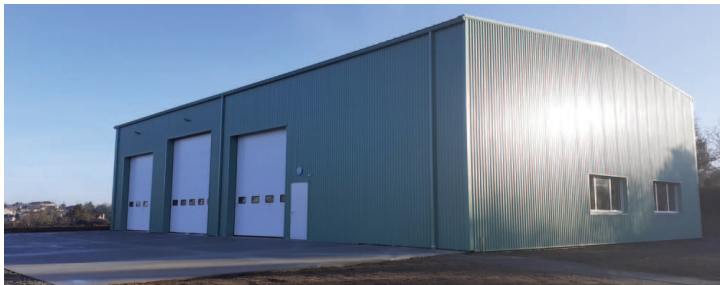
Le nouvel atelier en cours de finition.
